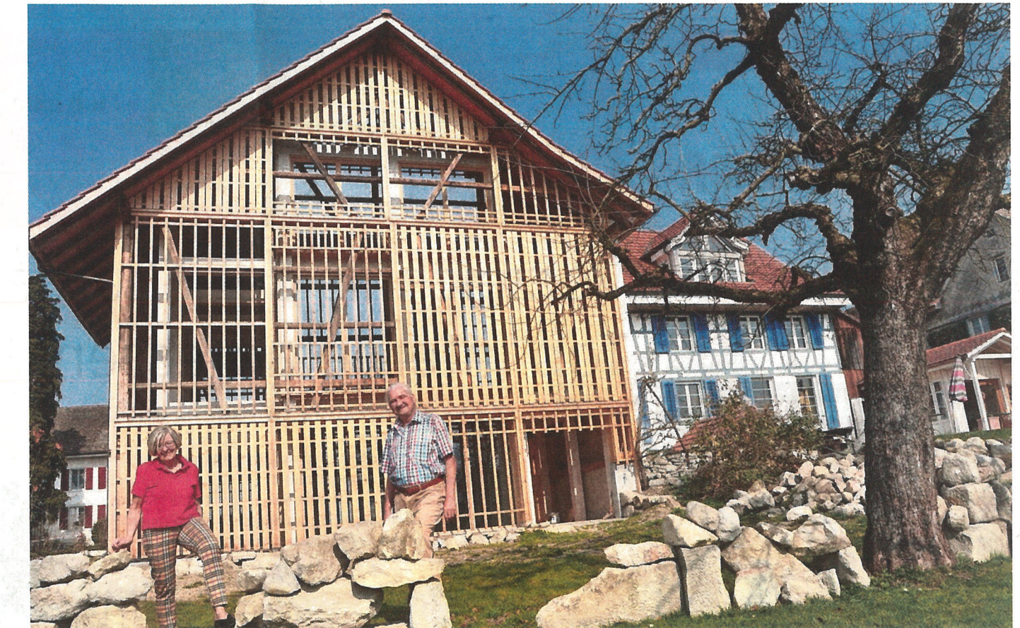
Die neue Fassade schützt den alten Riegel der Scheune und trägt die Handschrift von Roswitha und Martin Frey.
