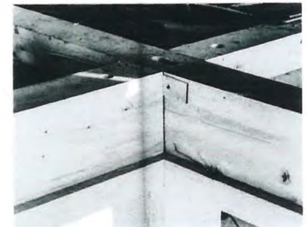
Die Knotenverbindung des Rasters bleibt im Endausbau unsichtbar. Da der Zugang eingeschränkt war, kamen nur kleine Bauteile zum Einsatz.
