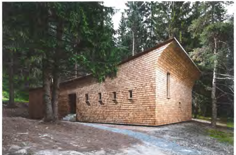
50 Poetisch schwingt die Hütte ihr Dach am Waldrand in Domat / Ems in die Luft.
