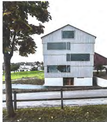
49 Die Lärchenfassade des Ausbildungszentrums in Salenstein ist fein detailliert.
