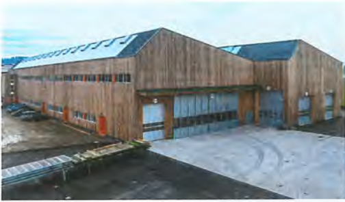
46 Die Montagehalle in Gossau ist präzise auf den Zweck abgestimmt.
