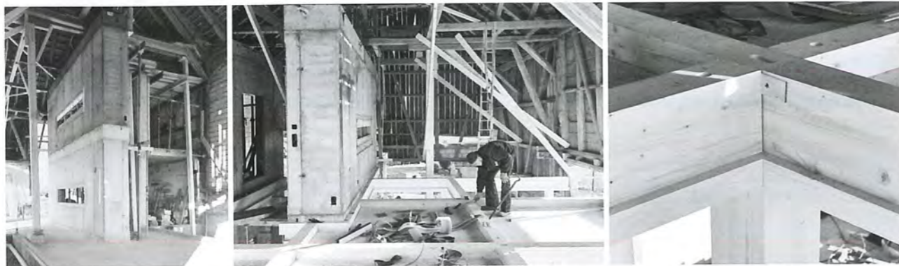
Zuerst wurden die Betonelemente gegossen wie etwa die Bodenplatte oder der (noch zweistöckige) Küchen Kern (links). Danach folgte der Einbau der neuen Tragkonstruktion (Mitte). Die neuen Träger laufen zum Teil durch die Knotenpunkte, sind T-förmig ausgebildet und erlauben so die Aufnahme der hölzernen Bodenplatten (rechts).
