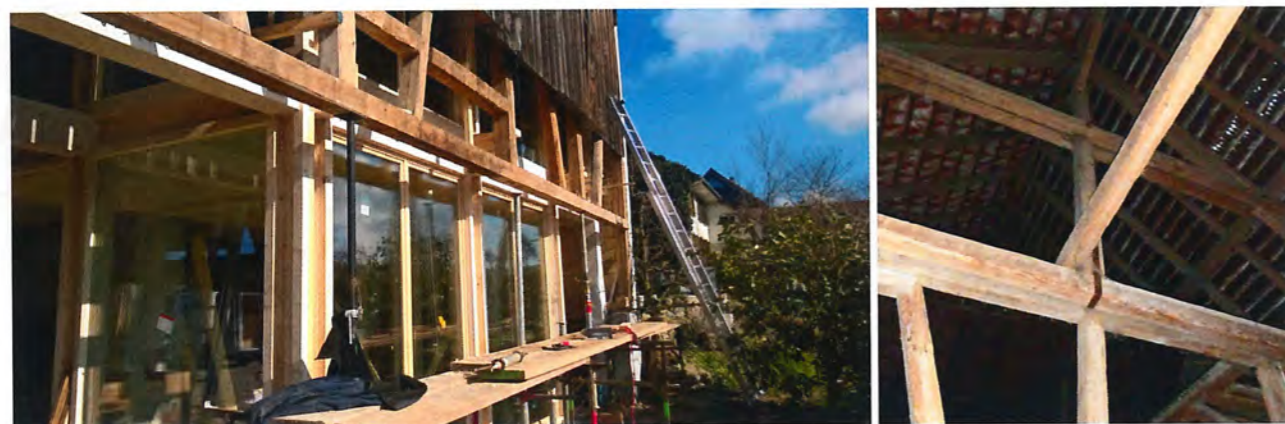
Die alten Balken wurden aufgefrischt und ergänzt, dahinter steht schon die neue Tragkonstruktion. Foto: Sommerhalder Holzbau
