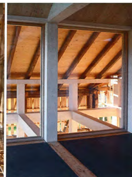
Die Neigung des bestehenden Scheundachs wurde in der Dachschräge der obersten Wohnung aufgenommen.
