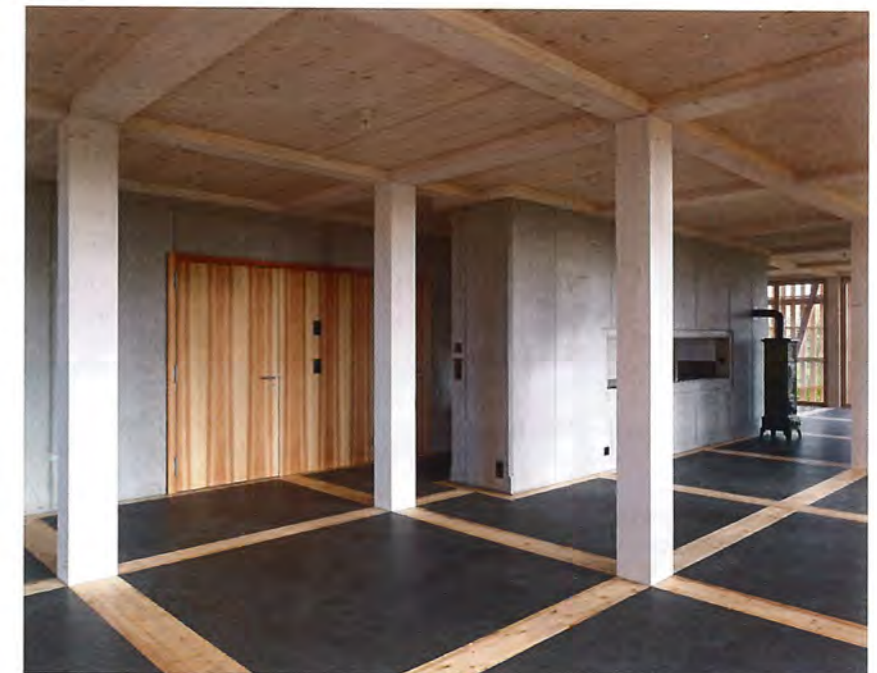
Verschiedene Raumkonstellationen lässt das innenliegende Tragwerk zu, dessen Feldeinteilung in der Regel 2,5 x 2,5 m beträgt.
