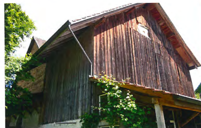
So sah die Scheune in Dingenhart aussen vor dem Umbau aus. Foto: SJB
