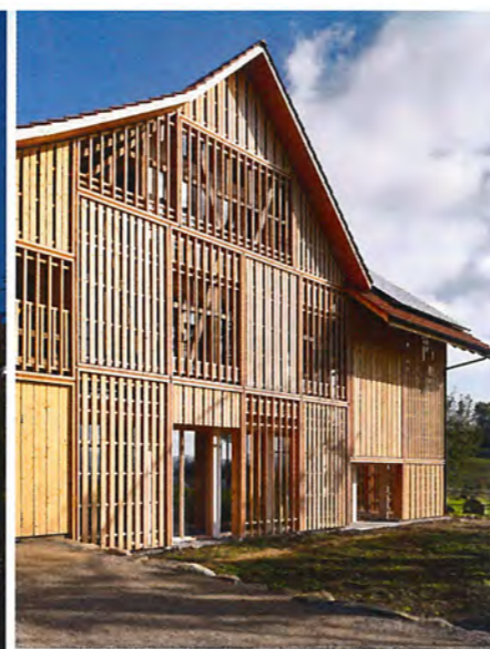
Aus seitlichem Blickwinkel lassen sich die verschiedenen Fassadenmuster gut erkennen.
